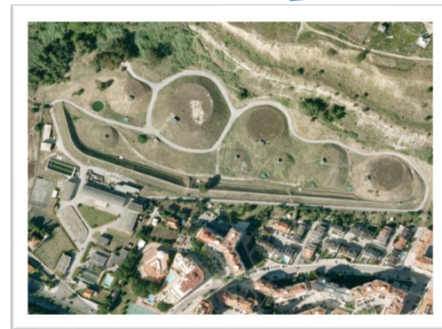
Reservatório na zona II
