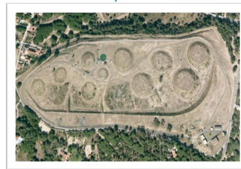
Reservatório na zona III
